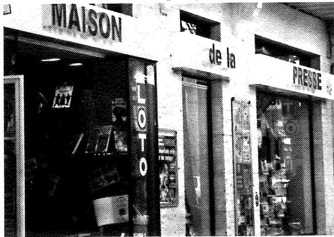
Sous les rênes de Robert Andurand, la Maison de la Presse à Auch agrandie et rénovée.
